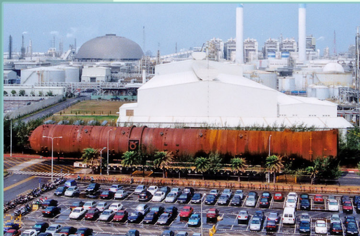
▲C7101 二苯甲高塔 Xylene Column SA516-70 \phi 8.5 m / 9.5 m x 91.7 m L x 1,489 Ton
